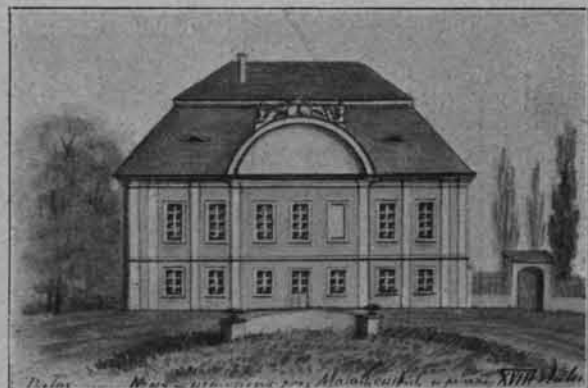
PALAC t. z. „NOWY”—PRZED PRZEBUDOWĄ rys. H. Wierciński.
