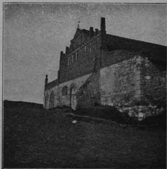
STODOŁA W ANDRUSZÓWCE, GUB. KIJOW. ze szczytem wzorowanym na budowach krakowskich, pomysłu Michała hr. Tyszkiewicza.
