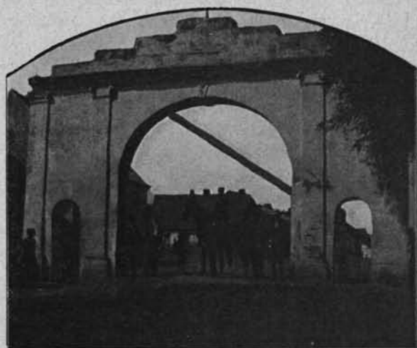
BRAMA WJAZDOWA W ŚLESINIE OD STRONY IGNACEWA.
