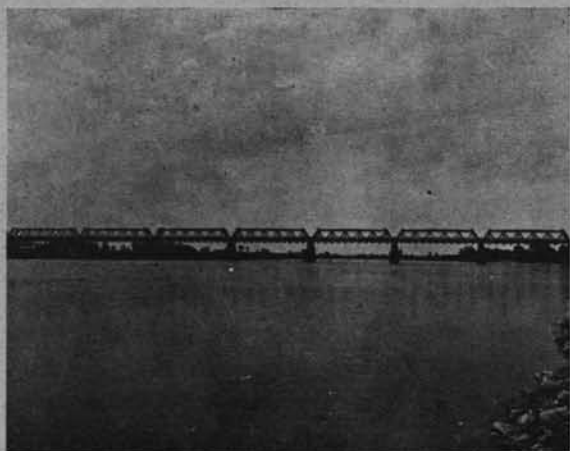
Ryc. 147. Fot. T. Dybczyński. Most drewniany na Wiśle pod Szczucinem. Zdjęcie z prawego brzegu Wisły.
