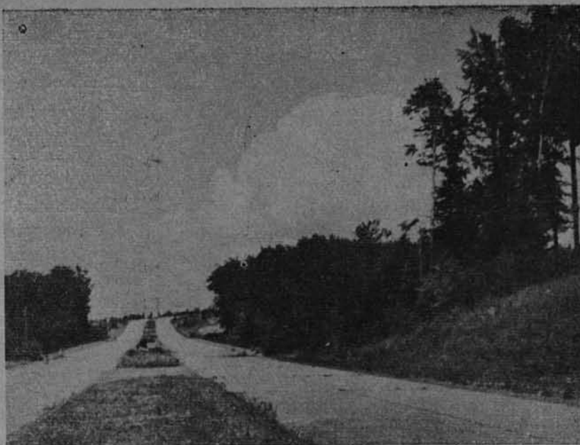
Autostrada na południe od Klucza.
