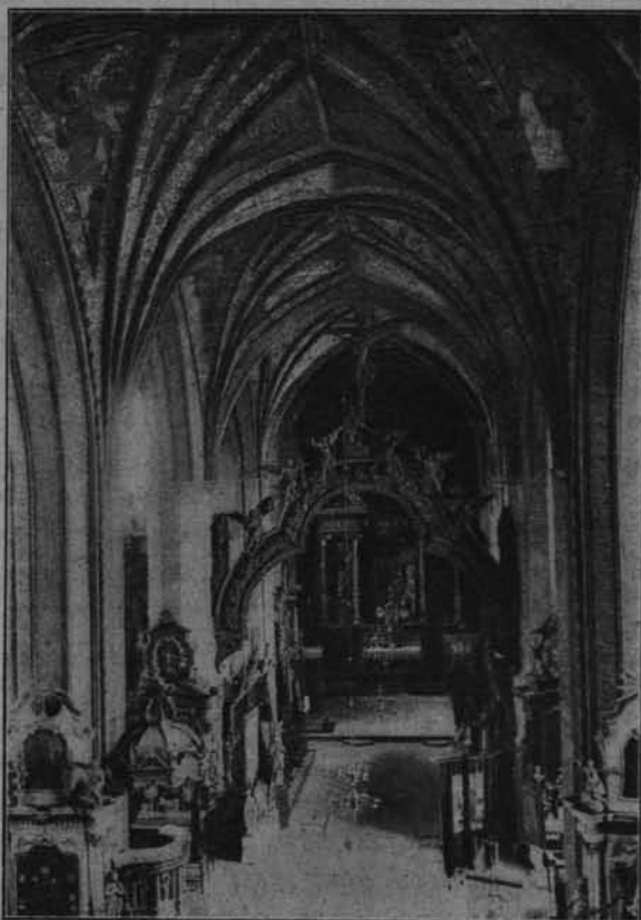
Ryc. 110. Ze zbiorów Książnicy. Fot. Marcinkowski. CHEŁMŻA. WNĘTRZE KOŚCIOŁA FARNEGO.
