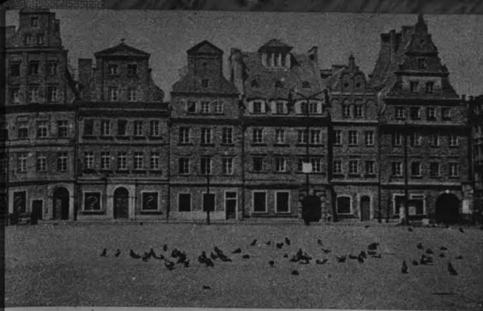
Powyżej: Wrocław. Odbudowane od podstaw kamieniczki na Placu Solnym.
