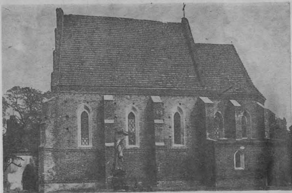
Kościół parafialny w Piotrawinie, widok od południa. Do niższego, wydzielonego prezbiterium, zamkniętego polygonalnie, dobudowano z boku zakrystię (1869), obecnie pełniącą funkcję kruchty. Wąskie rozglifione okna, wypełniające swą szerokością mniej więcej jedną trzecią przestrzeni międzyszkarpowych dowodzą pewnego prowincjonalizmu architektury. Widoczne są otwory maczulcowe oraz fryzy z cegły układanej na kant
