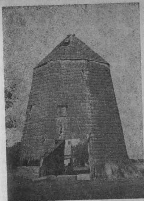
Budynek wiatraka holendra w Kamionce, zbudowany w 1910 r. ostatnio używany jako bróg do siana; własność Władysława Jaworskiego (stan z 1980 r.)
