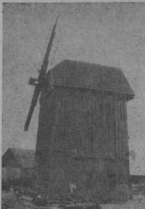
Koźlak w Latowiczu, zbudowany w 1839 r. w Parysewie, przeniesiony w 1937 r. na obecne miejsce; własność Witolda Strzeżka (stan z 1981 r.)
