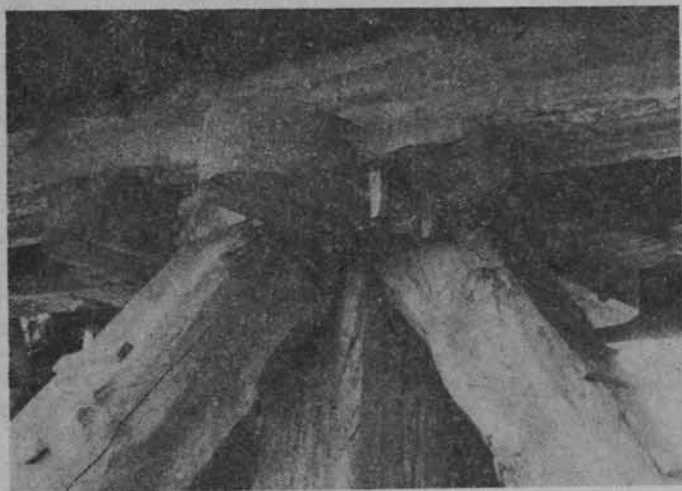
Górna część kozła — widoczne są zastrzały, sztember, siódło i pojazdy (Dąbrowa koło Siennicy)
