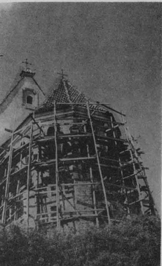
Prace konserwatorskie mające na celu rekonstrukcję kościoła Św. Trójcy. Fot. CAF — Trembecki.
