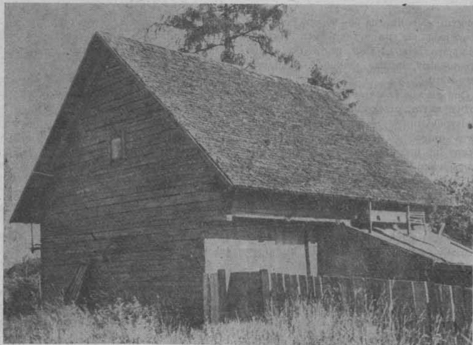
Spichrz z ok. 1880 r. w Jeziorkach. Szerokofrontowy, podcieniowy, czterostłpkowy. Dach slegowo-krokwiowy, kryty tradycyjnie wiórami
