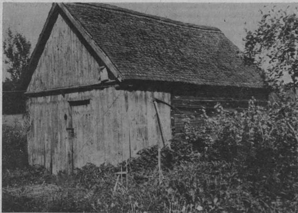
Spichrz z ok. 1900 r. w Studzianym Lesie. Waskofrontowy, podcieniowy, trzystupkowy, o konstrukcji zrębowej, o dachu krokwiowym, nie slegowym. Podcienie zabito deskami w późniejszym okresie, dla ochrony wejścia i powiększenia powierzchni tego małego spichrza
