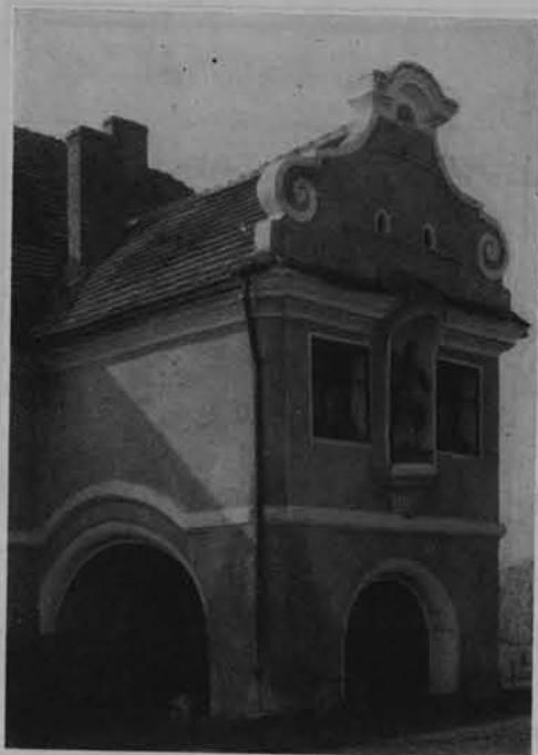
Ryzalit młyna wodnego z 1788 r. w Prudniku. Fot. Tadeusz Chrzanowski
