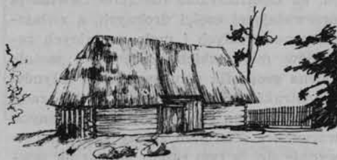
Stodoła z konstrukcją ślemienuwo-sochową z końca XVIII w., Bobrowniki, pow. Tarnowskie Góry, ul. Stawowa 3. Właśc. Sylwester Zdebel
