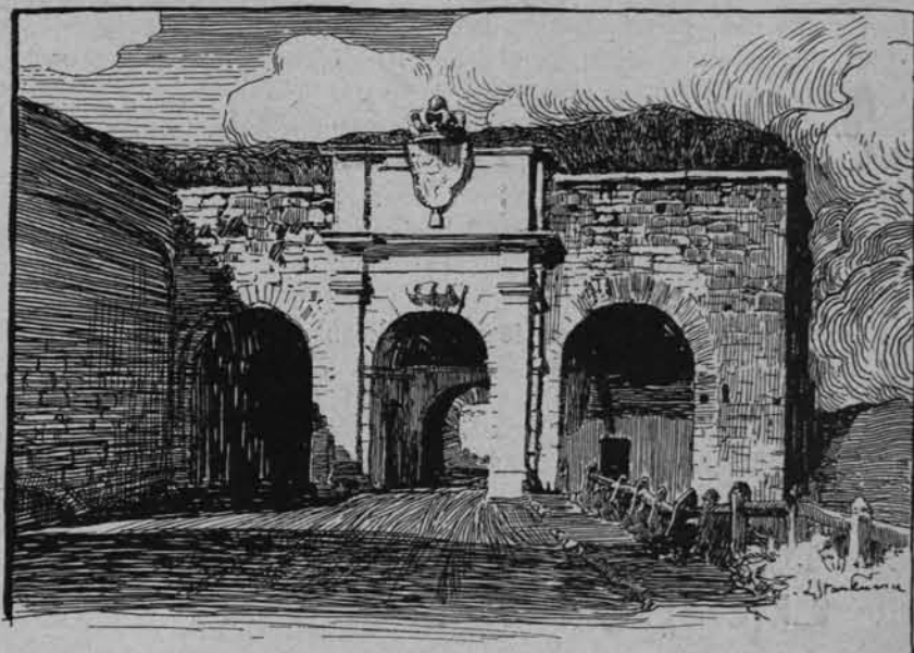
BRAMA WJAZDOWA W ZAMKU KAMIEŃCIEKIM (ZBURZONA W 1876 ROKU).
